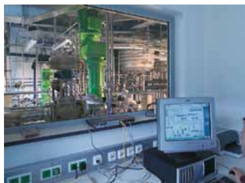
Вид со стороны поста управления блока ферментации.
